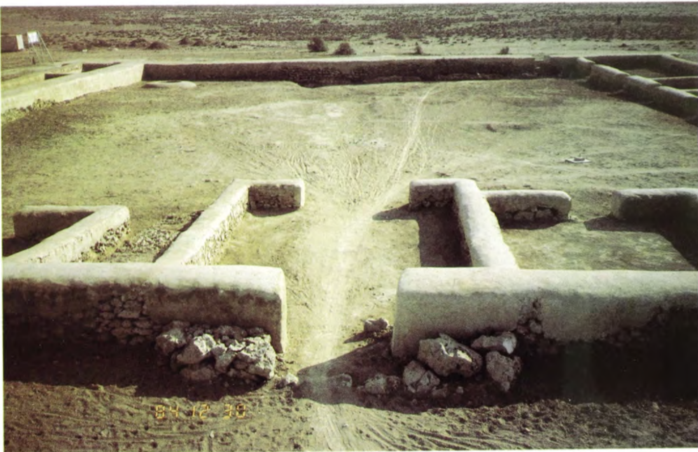
مروب - المدخل الرئيسي من الجهة الشمالية بعد الترميم
